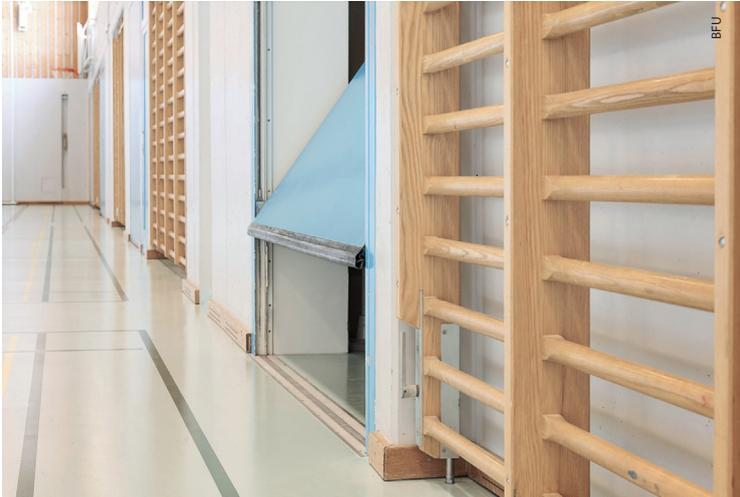
Geräteraumtor nach dem Prinzip der glatten Wand
